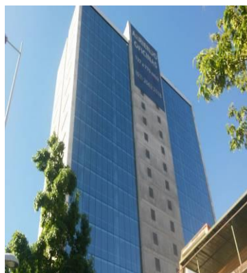
Fachada Norte (Calle Los Militares)
