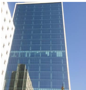
Fachada sur (Principal)
